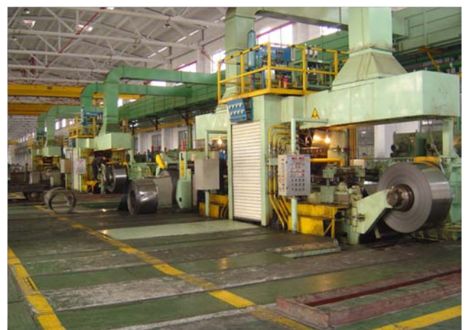
图3 河南鸽瑞公司650四辊可逆轧机液压AGC现场
