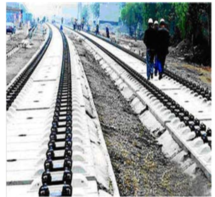
图1 京津高铁承轨台
