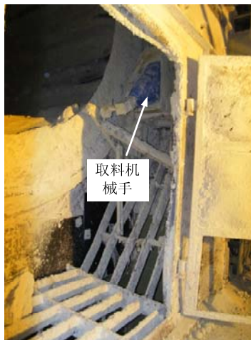
图1 取料机机械臂现场位置
