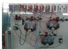
电气(继电器)回路搭接
